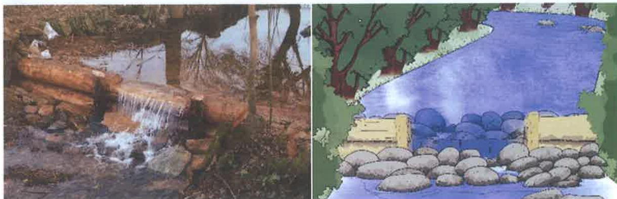
Figura 21 - Exemplo de travessão em pedra e madeira
