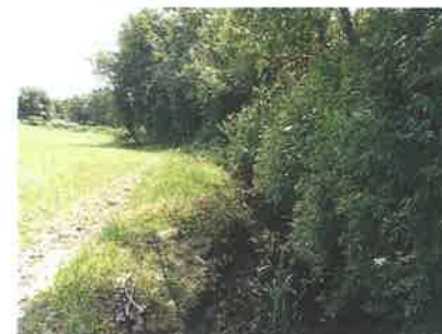
Vista de jusante para montante
