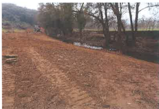
Figura 13 – Exemplo de ações para modelar as margens e garantir maior estabilidade (adaptado de Teiga, 2011)
