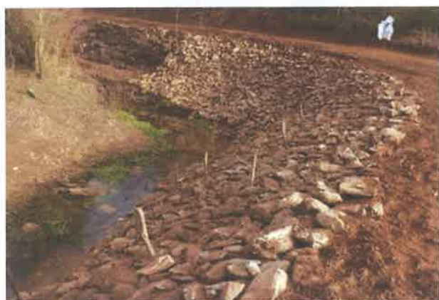
Figura 19 – Enrocamento vivo (fotografia, secção transversal e alçado)
