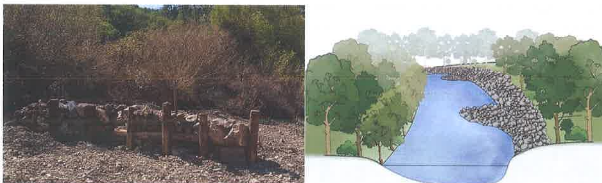
Figura 22 – Defletor de corrente (fotografia e alçado)
