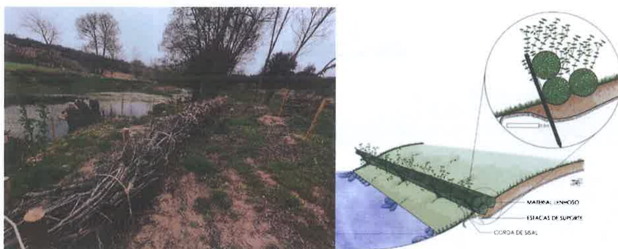
Figura 16 – Faxina viva (fotografia, secção transversal e alçado)
