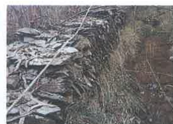
Margem direita regularizada com muretes de xisto
